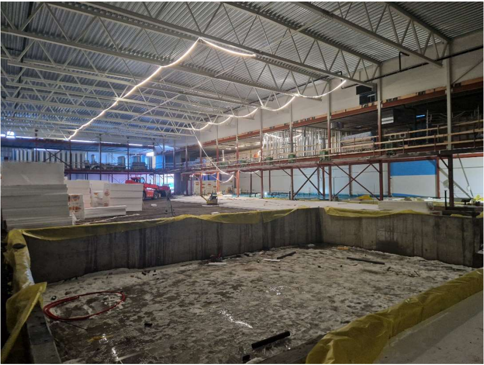
Bilder fra byggeprosjektet pr 23.02.2024.
